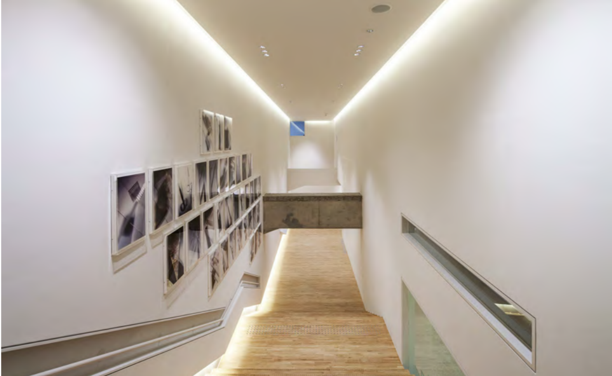
施設全体を回遊状につなぐプロムナードは既存スラブを撤去した吹き抜け空間。露しの梁は既存躯体を象徴的に表現。
