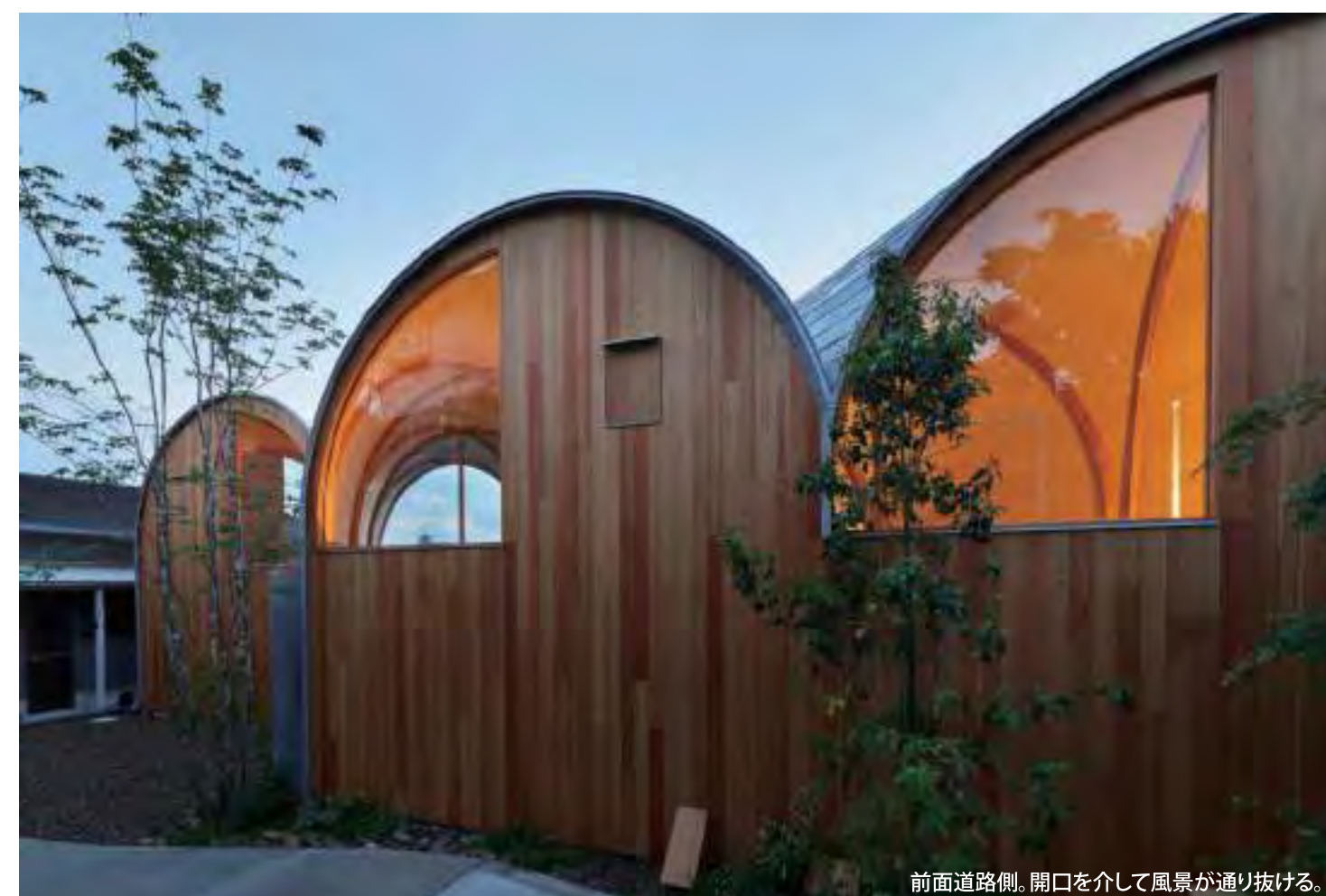
前面道路側。開口を介して風景が通り抜ける。
