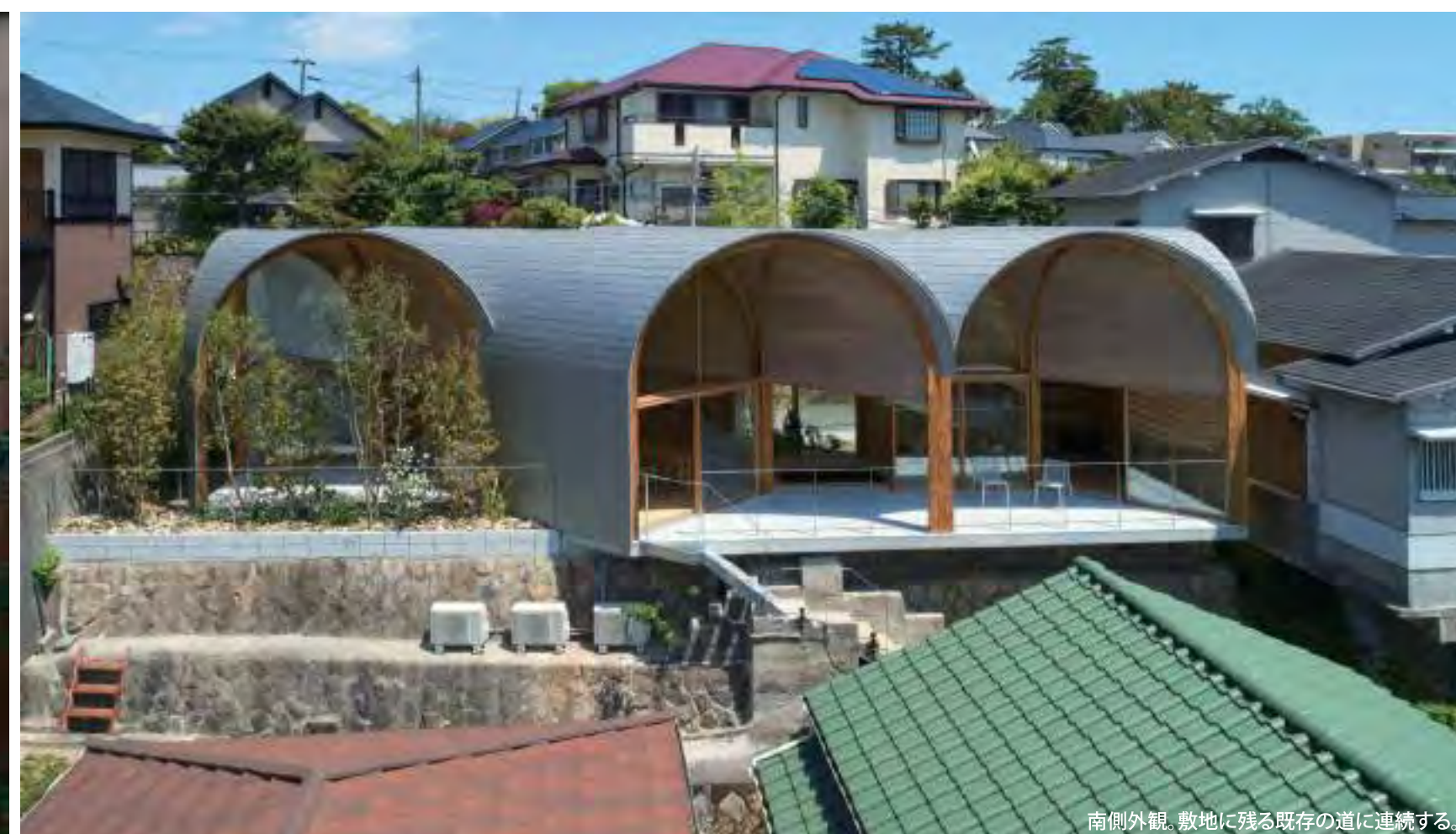
南側外観。敷地に残る既存の道に連続する。
