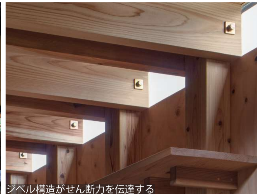
ジベル構造がせん断力を伝達する
