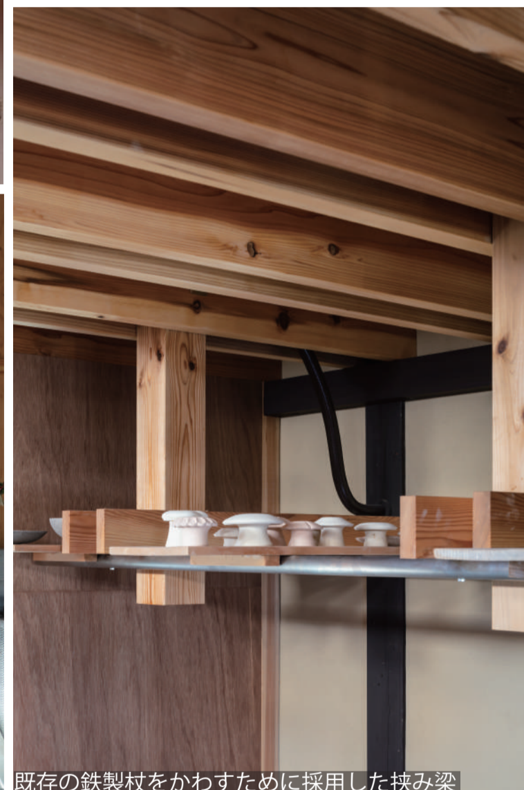
離れ床の間の片持ち梁を支持する束材
