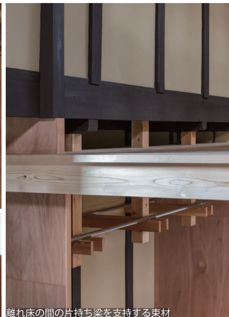
離れ床の間の片持ち梁を支持する束材
