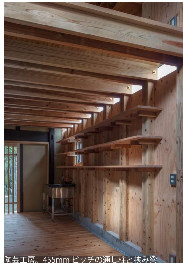
陶芸工房。455mmピッチの通し柱と挟み梁
